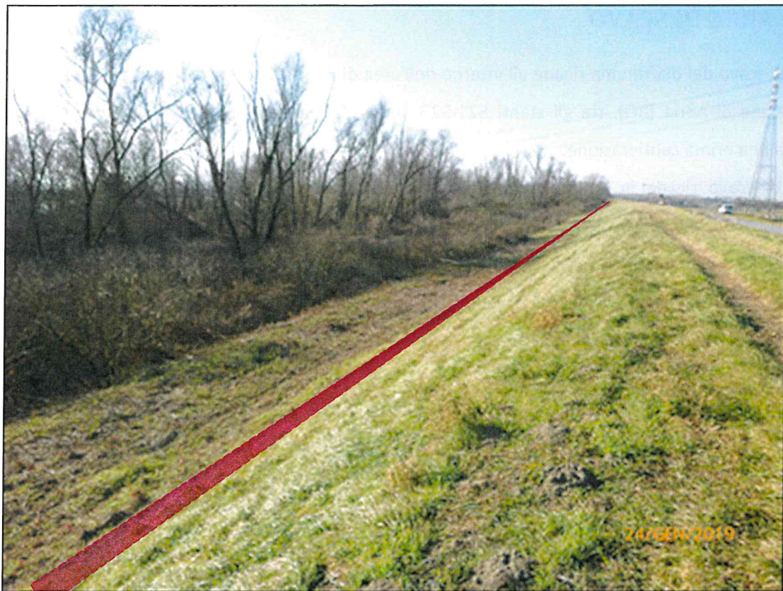
Fig. 6 – Foto dell’area d’intervento – petto a fiume con ubicazione dell’area di imposta del diaframma
