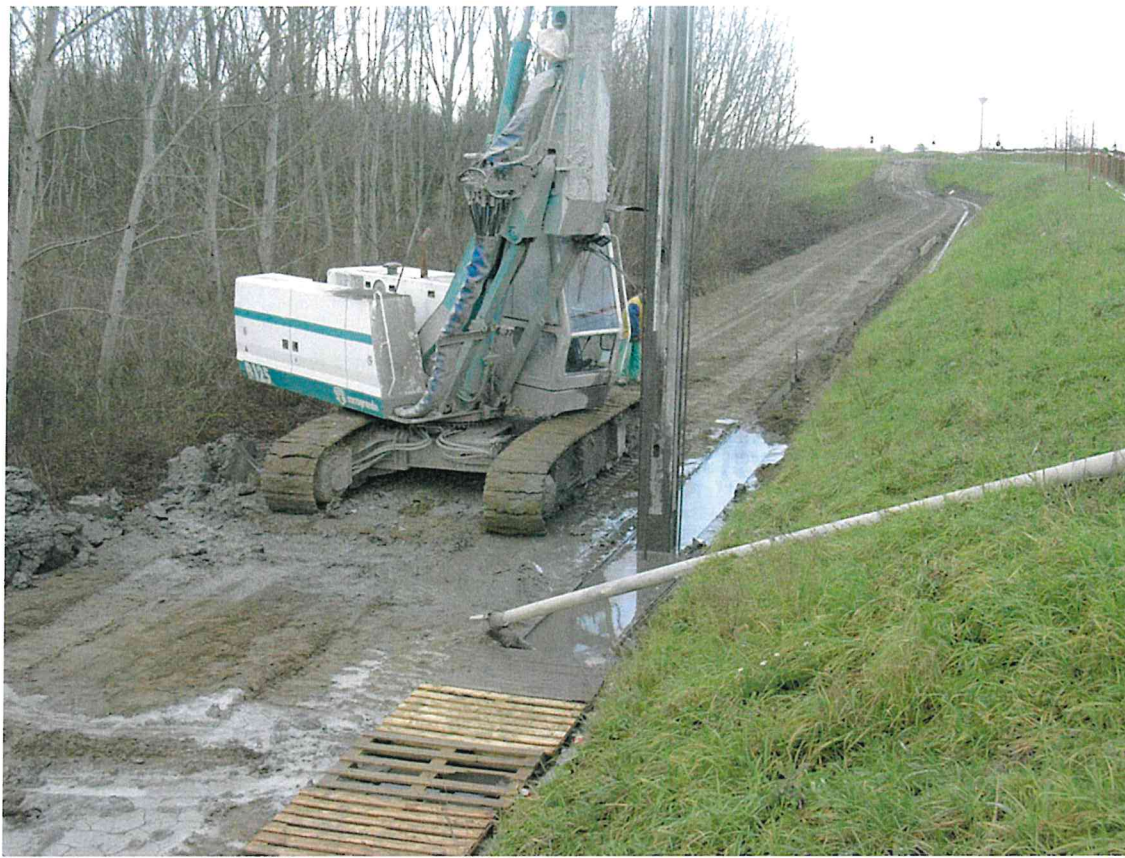
Fig. 3 – Fase di scavo del diaframma - intervento di classifica RO-E-1376 – Papozze (RO)
